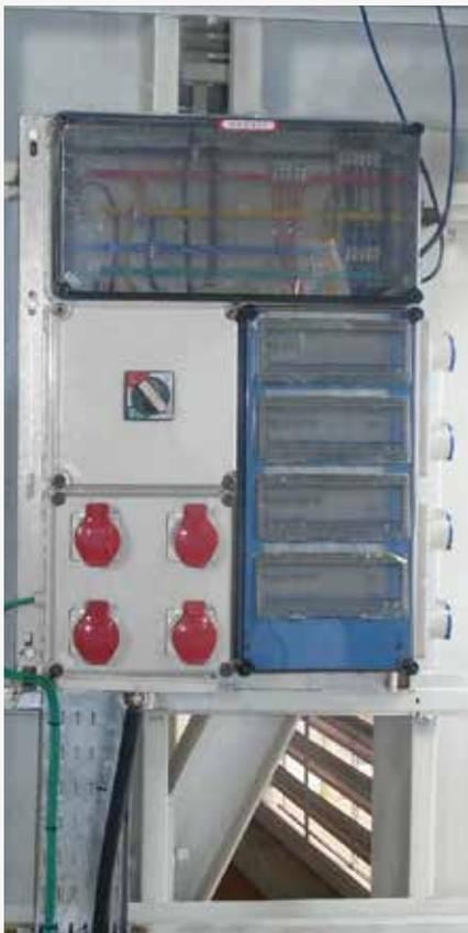
Werkstattverteilergehäuse mit CEE-Steckdosen, installiert in einer Maschinenbaufabrik
