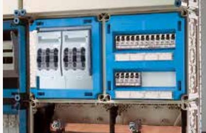
+ Berührungsschutzabdeckungen für Bedienelemente verhindern den direkten Kontakt nach dem Öffnen des Deckels.
