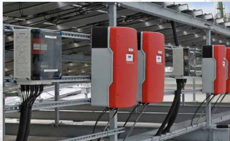
为了确保系统的最大可用性，总输出在多个电力逆变器之间进行分配。
