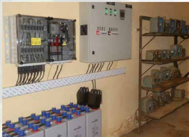
刚果铁路电气化，后备电源
