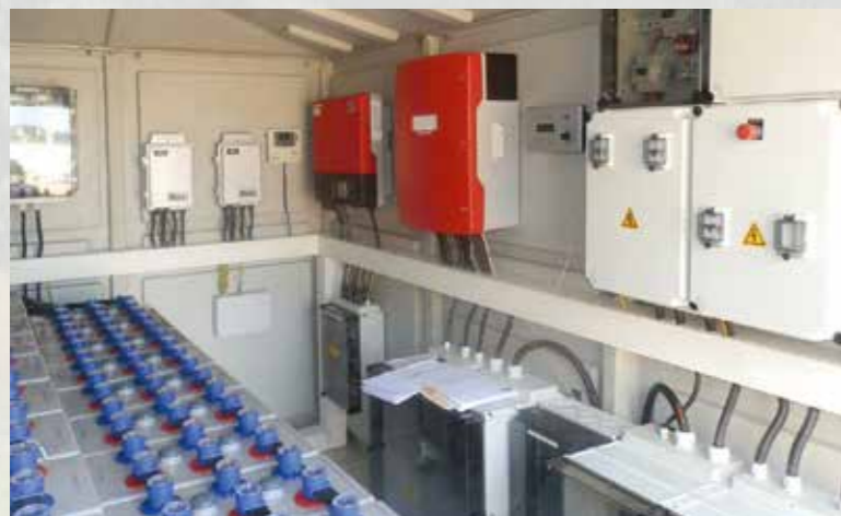
利比里亚一个村庄的电气化，配备光伏发电汇流箱、光伏发电逆变器汇流箱和电池组保护电池分配器
