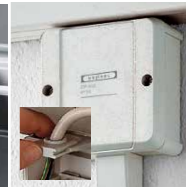
Pro instalace do lištových a trubkových rozvodů 1,5 mm 2 do 2,5 mm 2
