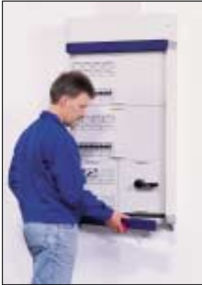
1. Demontage der unteren Frontblende.
