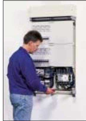
3. Demontage der Kabelein- führungswand unten.
