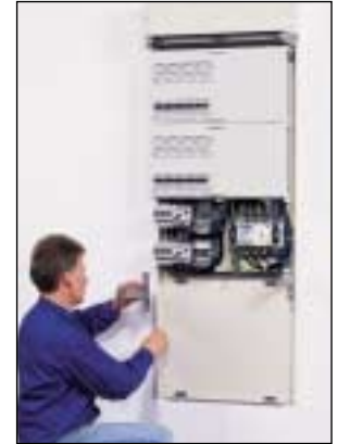
4. Anbau der neuen Rückwand mit zwei Höhenverbindern.
