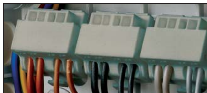
Anschließen von flexiblen Leitern: Schraubendreher öffnet Klemme, verdrehen Leiter mit Hand einschieben
