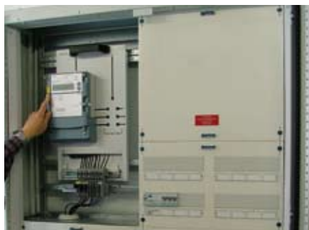
Beispiele: Stahlblech-Verteiler bis 2.800 kVA mit Messeinrichtung gemäß den Vorgaben des VNB
