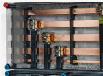
Esimerkiksi eristemateriaalista valmistettuihin tukiin kiinnitetyt virtakiskot.
