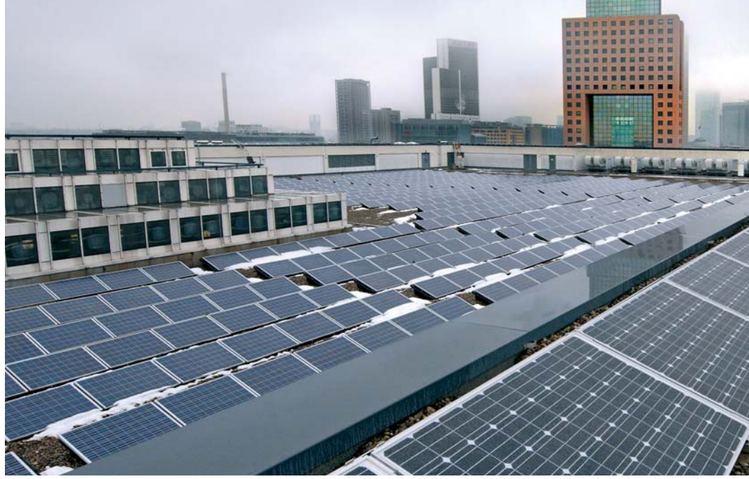
Salon 10 çatısındaki 3.500 m 2 'lik modül yüzeyine, toplam gücü 490 kWp olan 2.097 güneş modülü yerleştirilmiştir.
