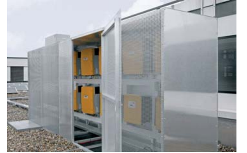
İnvertör ve invertör bağlantı panoları toplayıcı için hava şartlarına karşı koruma muhafazası
