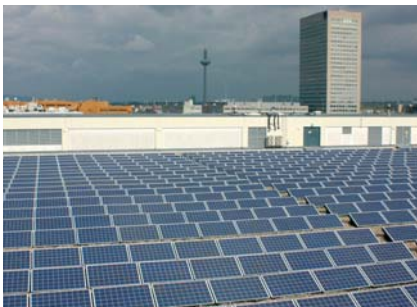
Sistemdeki 190 kWp'lık kapasite artımı
