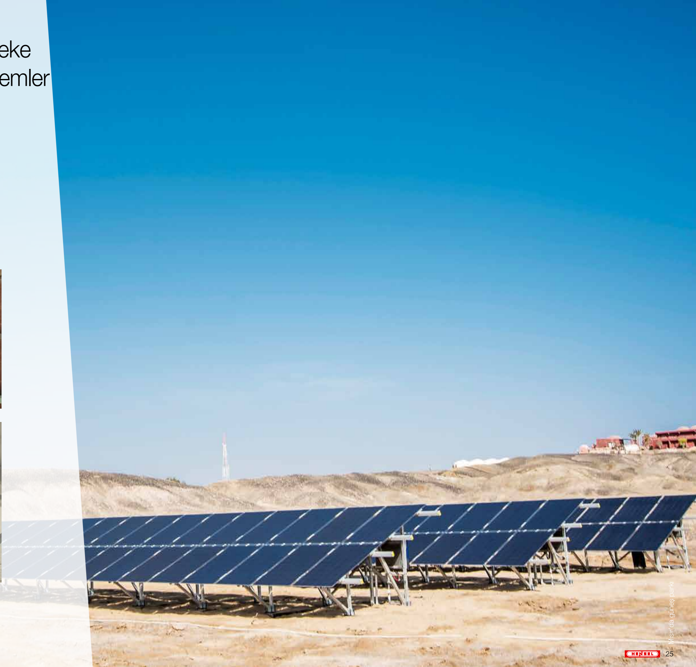
Şebekeden bağımsız bir su pompası sistemi için çöldeki bir su kaynağına yakın PV dağıtım panoları
