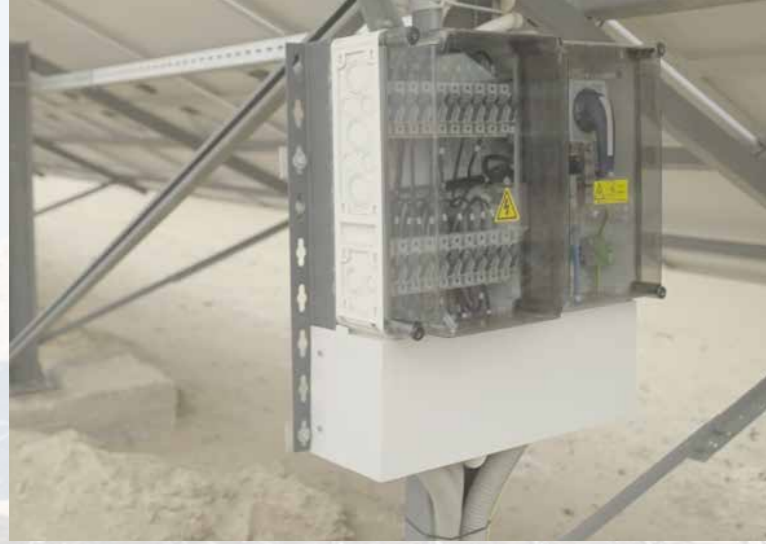
Şebekeden bağımsız bir su pompası sistemi için çöldeki bir su kaynağına yakın PV dağıtım panoları
