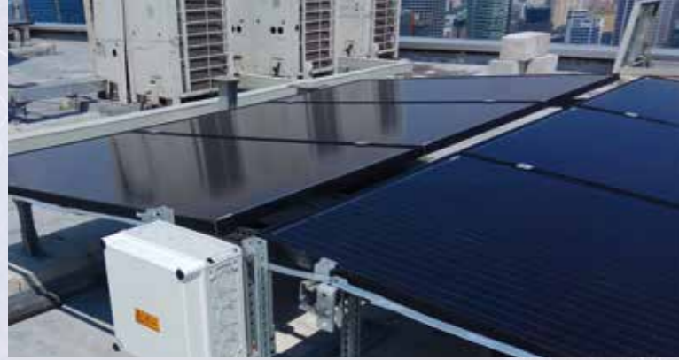
Marina Bay Sands Hotel'in çatısına çok sayıda PV jeneratör bağlantı kutusu yerleştirilmiştir.
