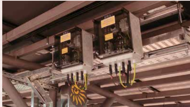
Çok sayıda Hensel PV jeneratör bağlantı kutusu, üretilen PV elektriğinin güvenilir dağıtımını sağlar.
