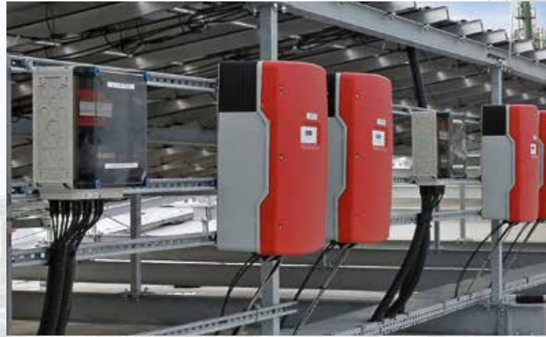
En yüksek sistem kullanılabilirliğini sağlamak için toplam çıkış birkaç güç çevirici (inverter) arasında dağıtılır.
